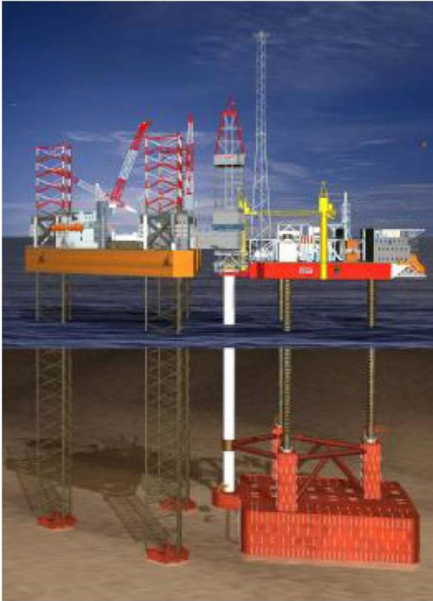
Figur 11. Borerigg og produksjonsfasiliteten med lagerenhet på bunnen.
