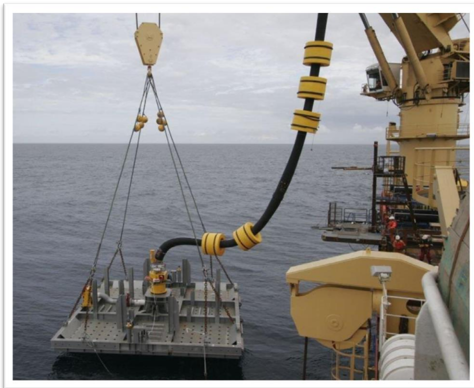
Figur 2-6. Lossesystemet ved installering.
