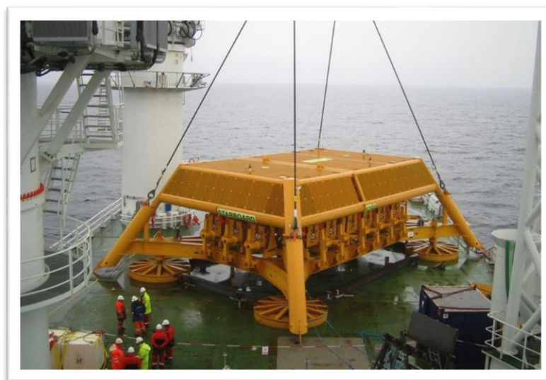
Figur 2-5. Illustrasjon av Yme Beta installasjoner i forgrunnen (øverst). Foto av Yme manifoldstruktur om bord på installasjonsfartøyet «Normand Installer» før installasjon på feltet.
