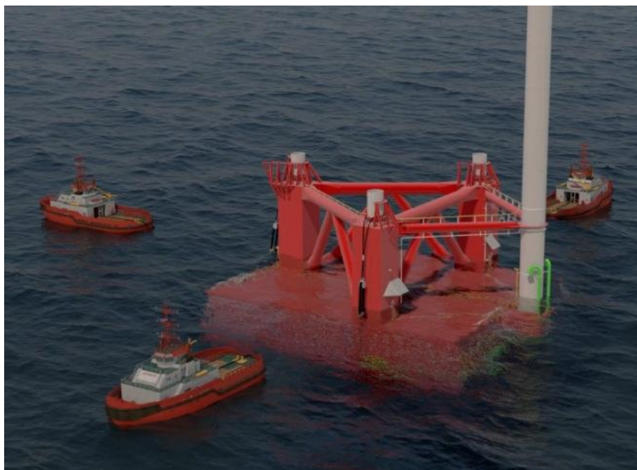
Figur 2-13. Illustrasjon av taueoperasjon av tanken etter at den er hevet til overflaten og sikret tilstrekkelig stabilitet.
