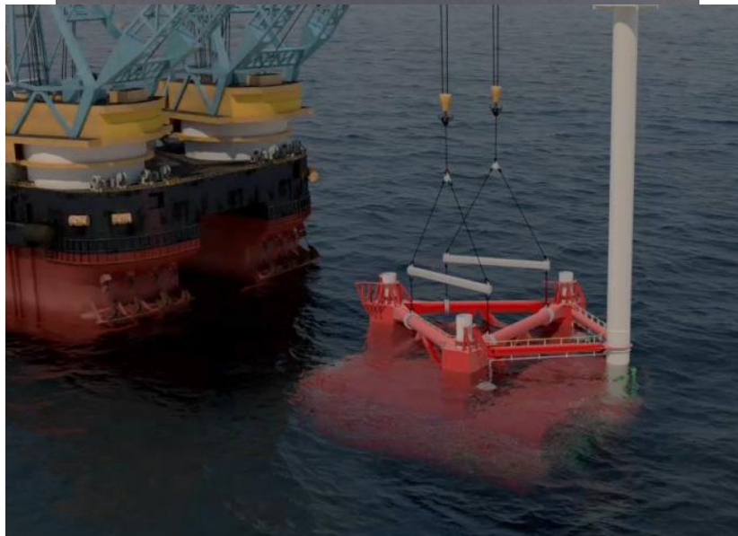
Figur 2-12. Illustrasjoner som viser hvordan heveoperasjonen kan foregå. Øverst er tanken løs fra bunnen og betongen ligger igjen på sjøbunnen.
